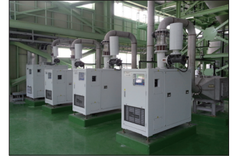
Sudokwon Landfill Site(NX150), Korea
